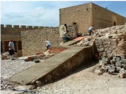
Operarios trabajan en las obras del castillo de Alcaudete. Foto: Comas
